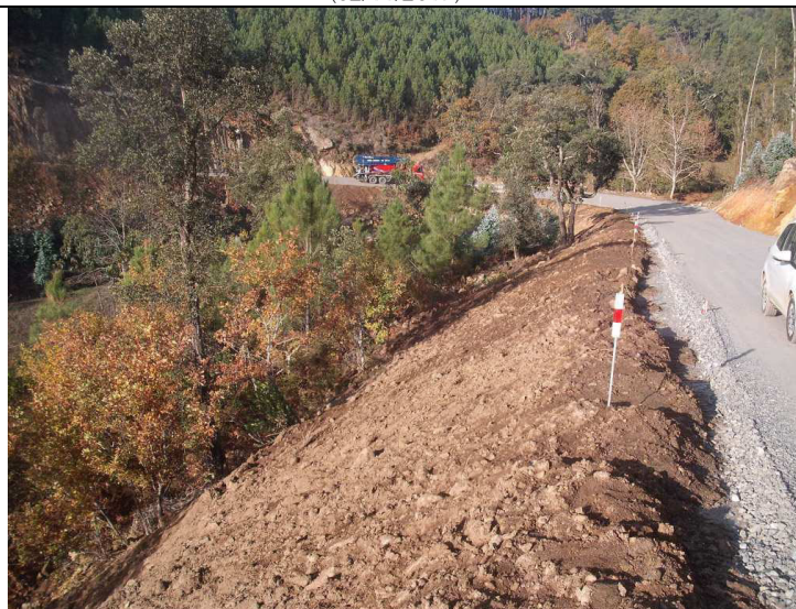
Figura 5 – Deposição de terra vegetal (reutilização em integração paisagística) no acesso C25 (05/12/2017)
