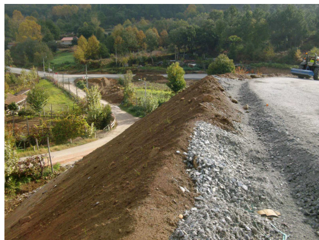
Figura 4 – Deposição de terra vegetal (reutilização em integração paisagística) no acesso B2/C2 (03/11/2017)
